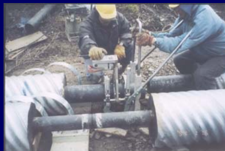
Sistema de distribuição
