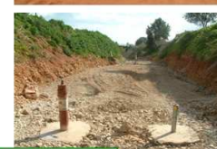
2) Caso de estudo de Carreiros 2 Bacias de infiltração no leito do rio Seco
