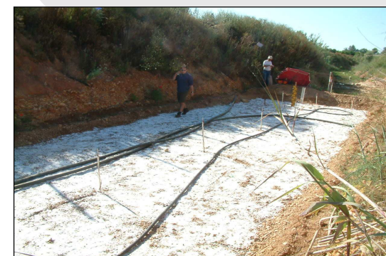
Colocação do traçador
