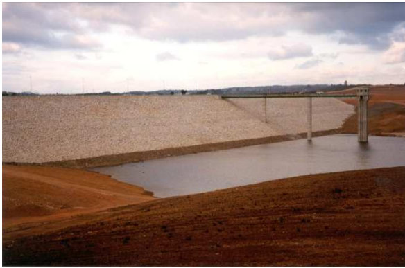
Figura 2 – Barragem do Sabugal, paramento de montante.
