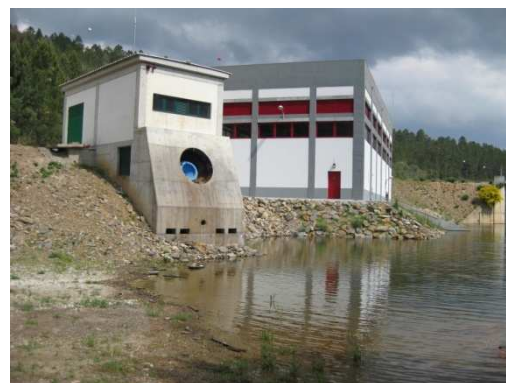
Figura 17 – Central do Meimão, edifício e válvula de jacto oco.
