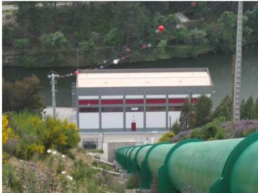
Figura 14 – Central do Meimão, vista da central e da conduta forçada.
