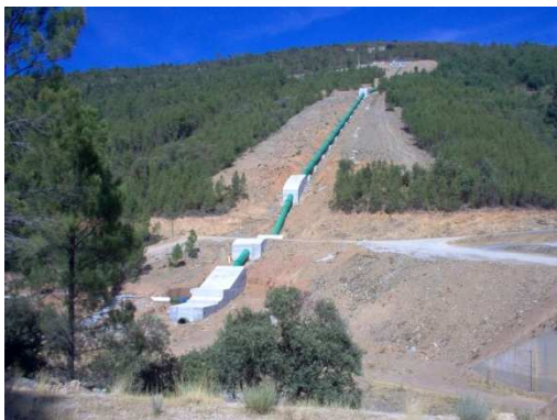
Figura 9 - Circuito Hidráulico Sabugal-Meimoa, conduta forçada.
