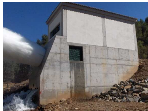
Figura 10 - Circuito Hidráulico Sabugal-Meimoa, válvula de jacto oco.
