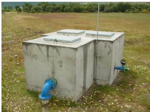
Figura 23 – Rede secundária de rega, hidrante.
