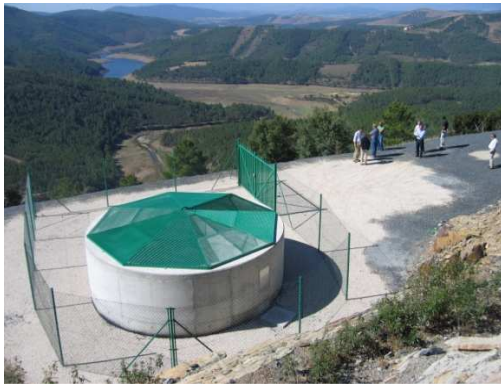
Figura 11 - Circuito Hidráulico Sabugal-Meimoa, chaminé de equilíbrio.
