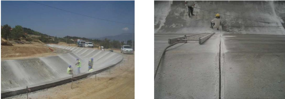
Figura 18 - Abertura de juntas de retracção
