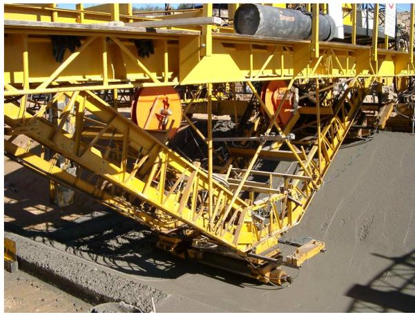
Figura 15 - Pavimentadora utilizada no 1º e 2º troços do CCG da Cova da Beira
