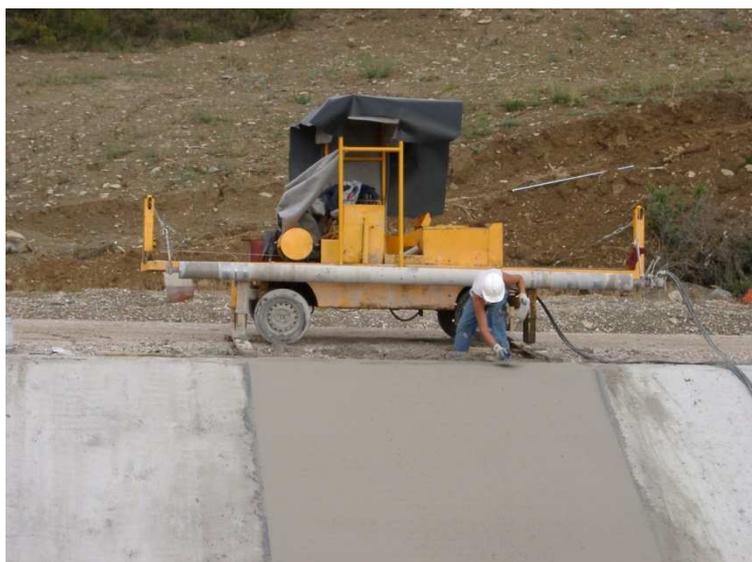
Figura 14 - Máquina vibratória
