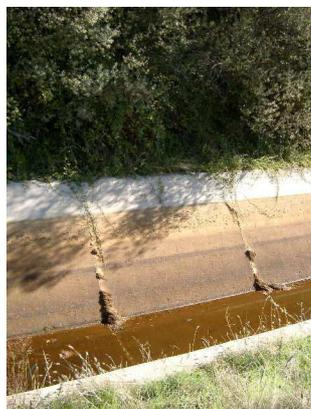
Figura 1 – Vegetação em contacto com o revestimento
