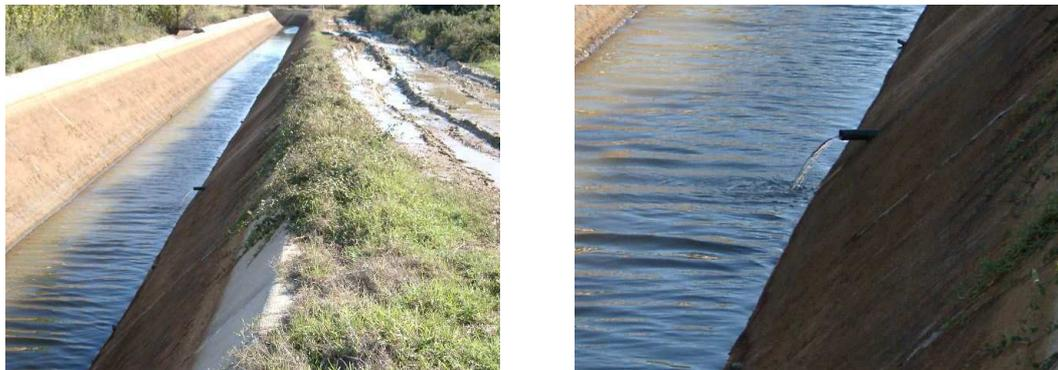
Figura 6 – Canal sujeito a sub-pressões resultantes de má drenagem
