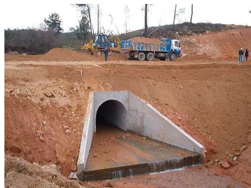
Figura 5 - Construção de passagens hidráulicas
