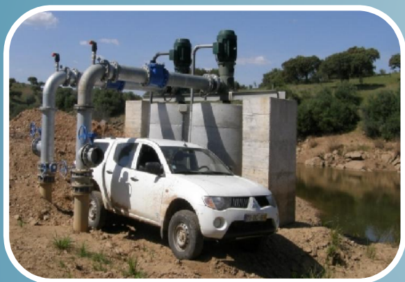
Captação por poço drenante na margem
