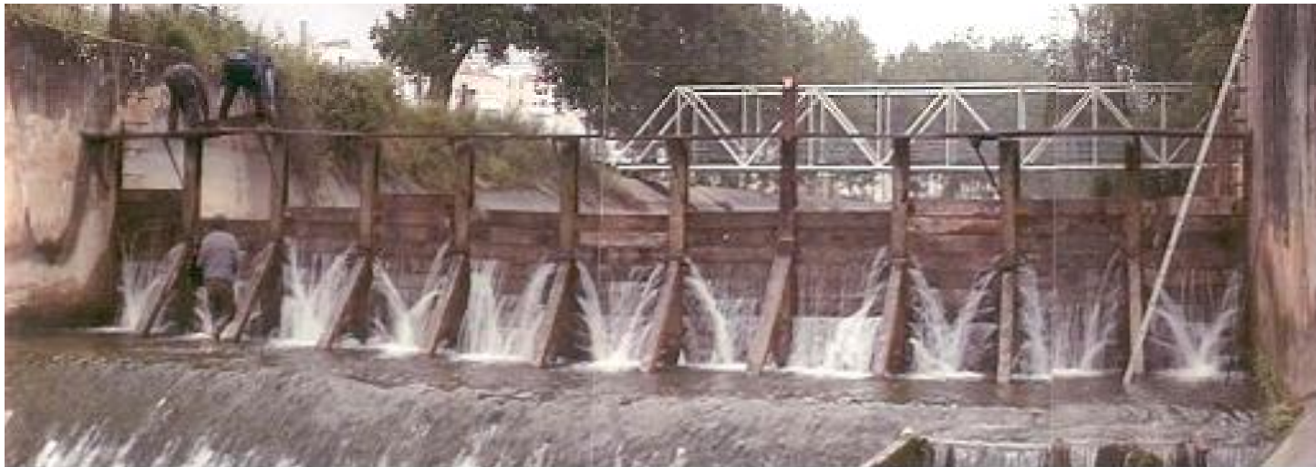
Arrabalde - aspecto da montagem do açude antes da reabilitação
