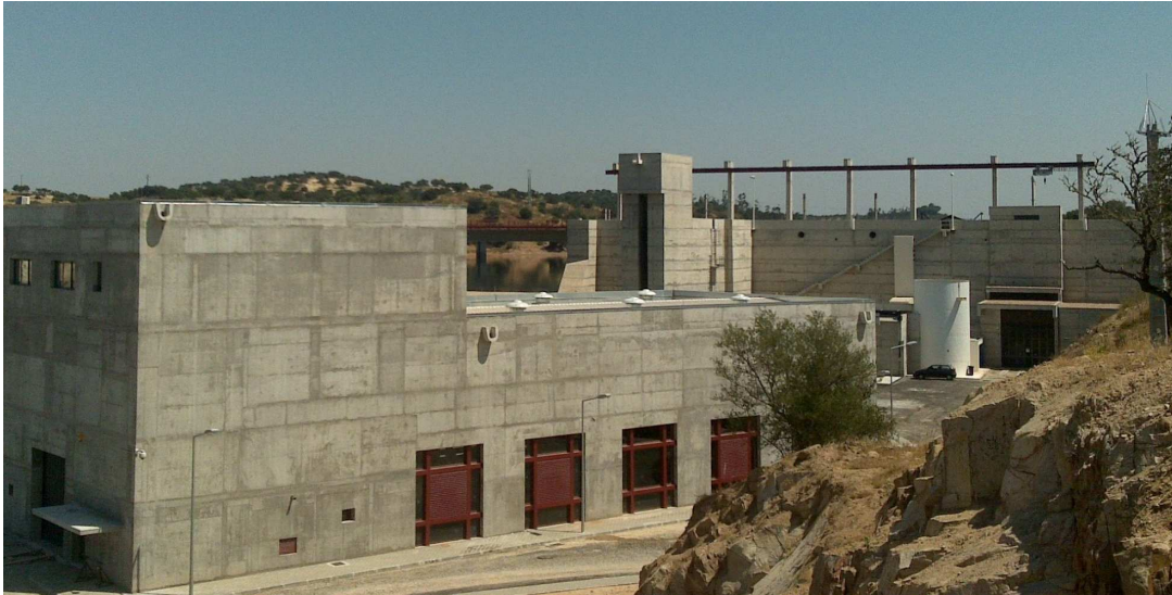
Figura 3 – Estação Elevatória do Pedrógão - Margem Esquerda. Vista geral, com o acesso à mini-hídrica do Pedrógão a montante (foto cedida pelo Eng.º Morim Oliveira).
