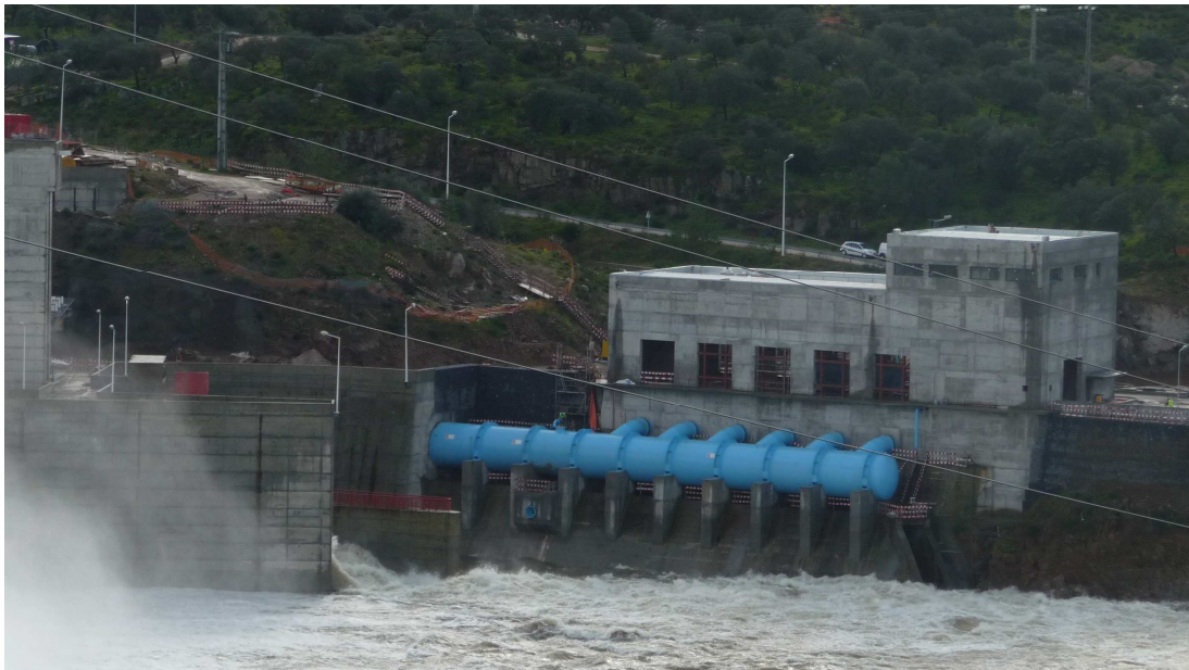
Figura 4 – Estação Elevatória do Pedrógão - Margem Esquerda. Vista a partir da margem direita.
