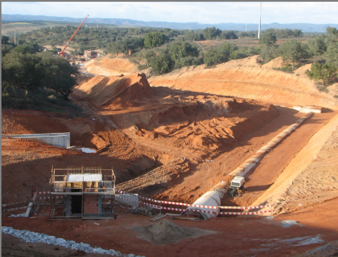
Reservatório de Orada e conduta elevatória Fase de construção.
