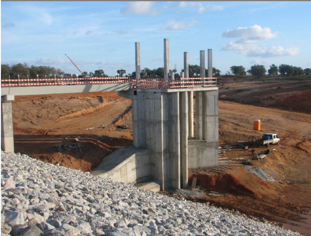
Reservatório de Orada. Vista da estrutura de entrada de água e da tomada para o canal
