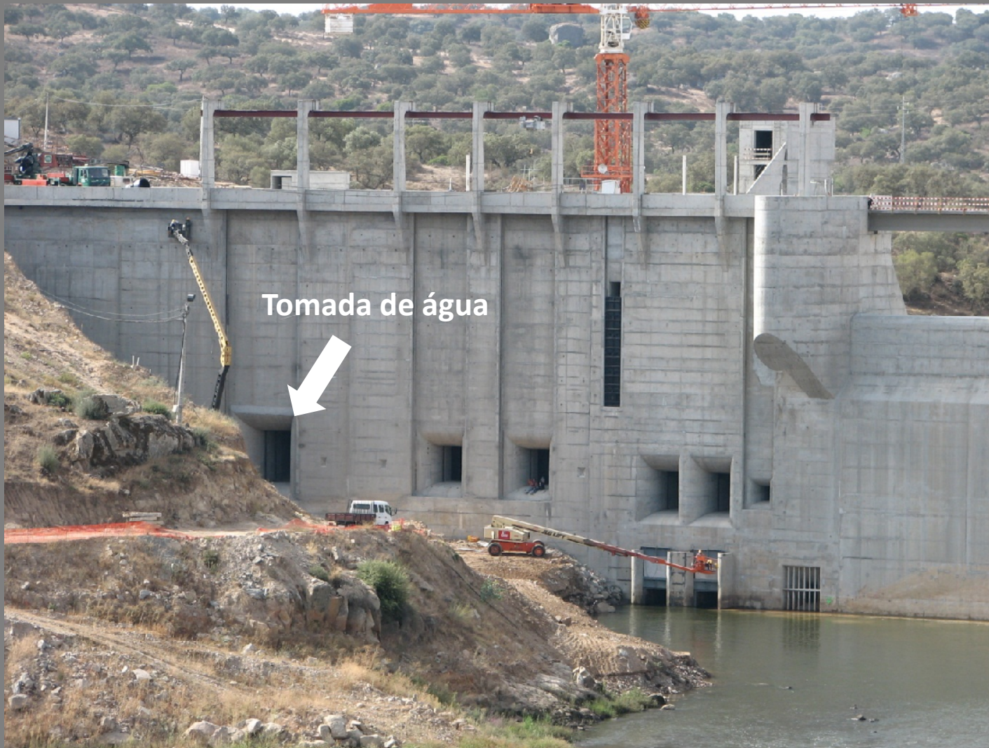
Barragem do Pedrógão. Vista do paramento de montante.
