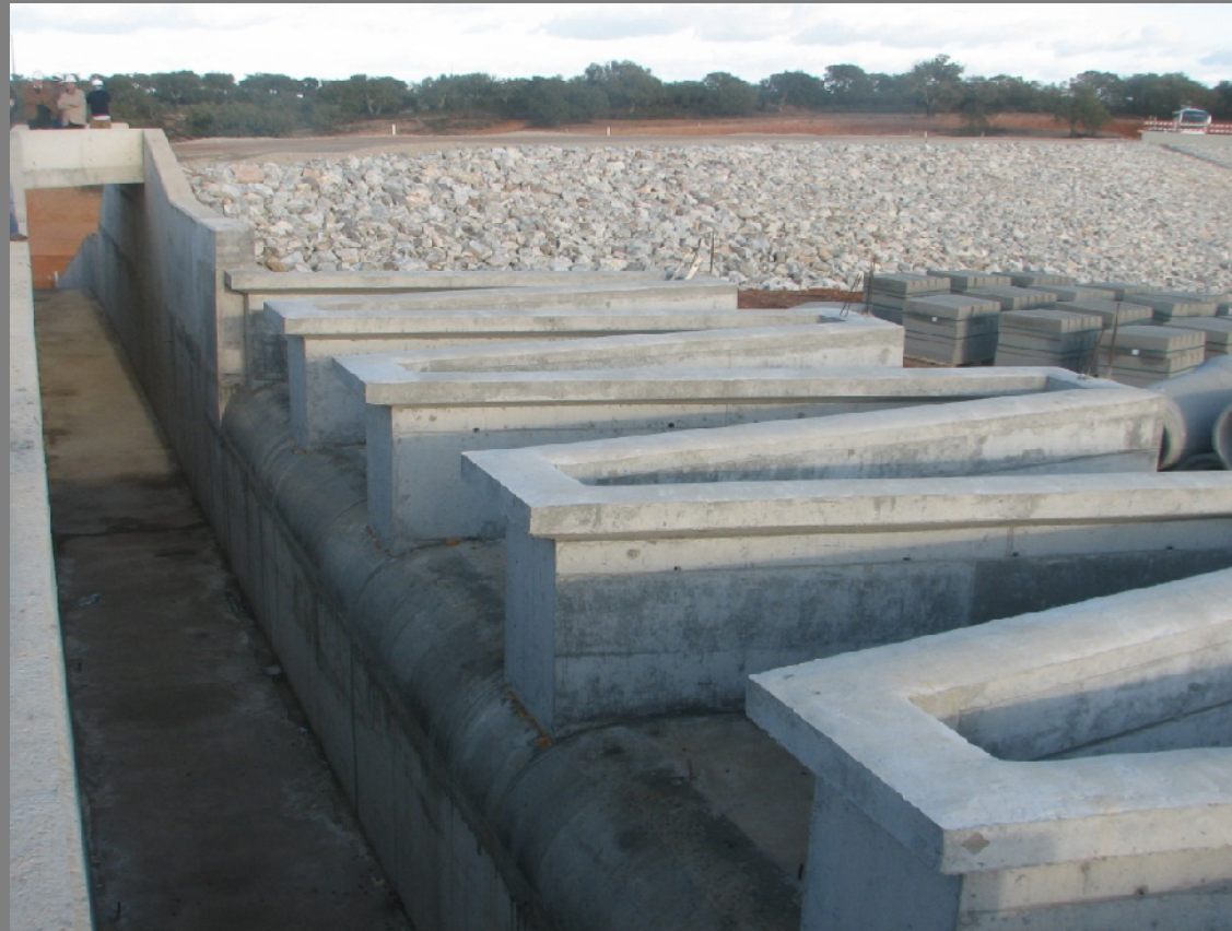
Reservatório de Orada. Pormenor do descarregador de cheias e aspecto do paramento de montante do aterro
