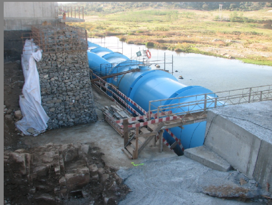
Estação elevatória do Pedrógão-Margem Esquerda. Fase de construção Conduto de adução
