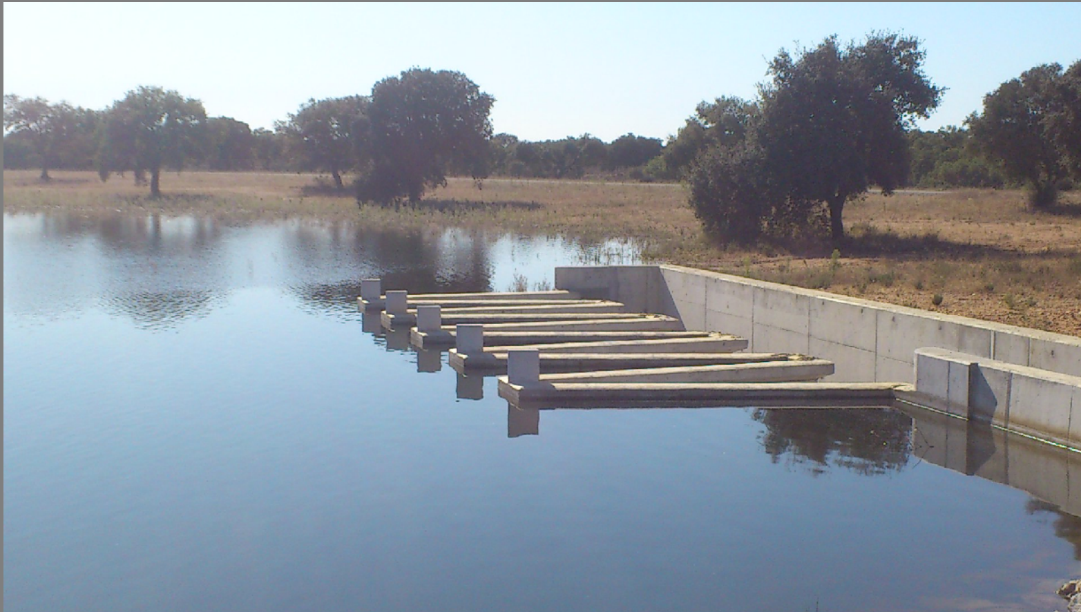
Reservatório de Orada. Pormenor do descarregador de cheias e aspecto do paramento de montante do aterro
