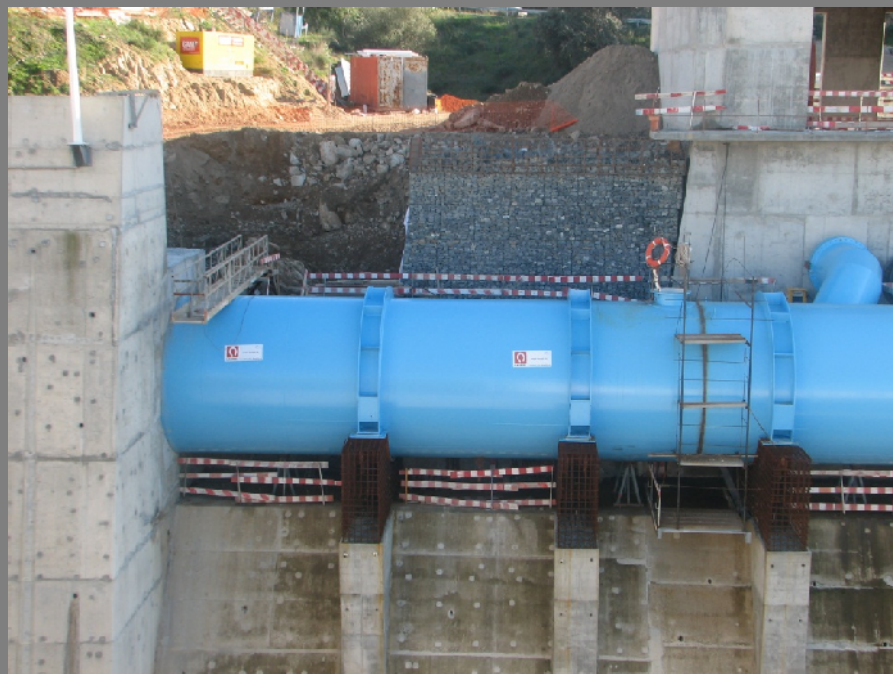
Estação elevatória do Pedrógão-Margem Esquerda. Fase de construção Conduto de adução
