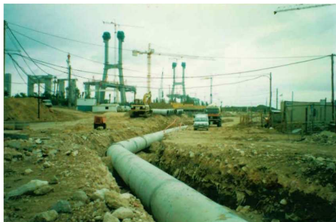
Figura 9 –Conduto de água da Central Térmica do Parque das Nações– DN 900
