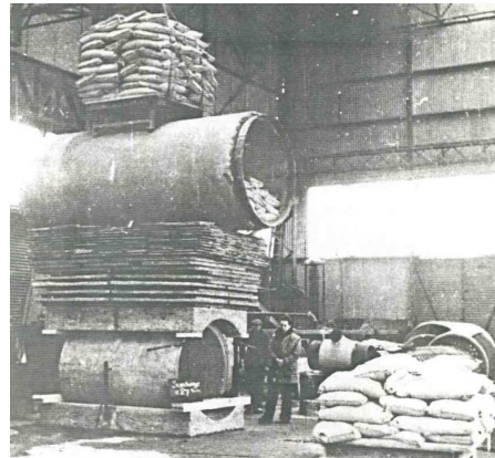
Figura 2 – Ensaio de compressão diametral ... em 1895
