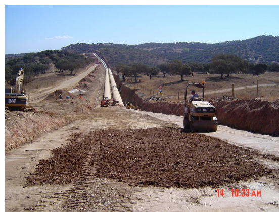
Figura 18 – Aterro final da conduta
