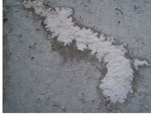
Figura 22 – Colmatagem de fissura
