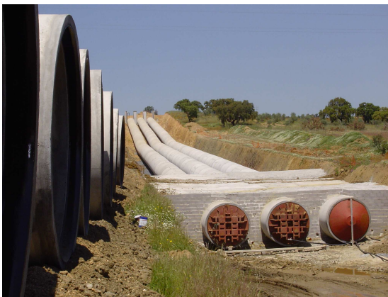
Figura 17 – Prova de estanqueidade da conduta
