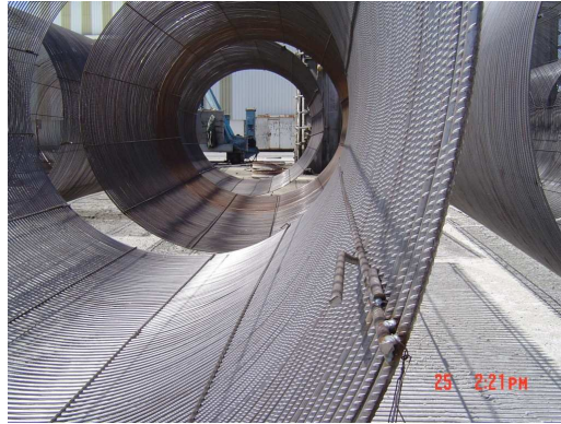
Figura 12 – Fabrico de tubos armados: etapa da produção das armaduras
