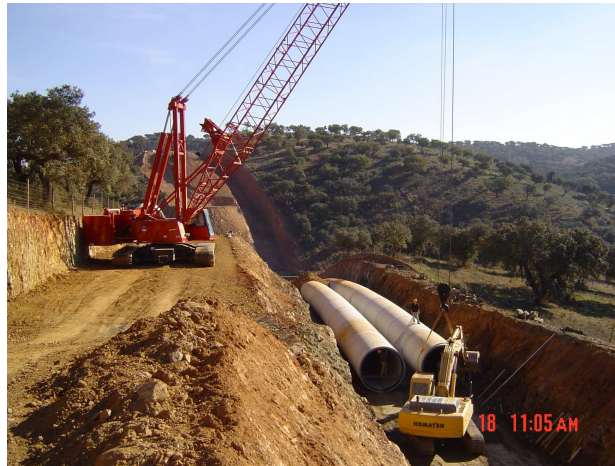
Figura 15 – Movimentação de tubos – colocação em vala
