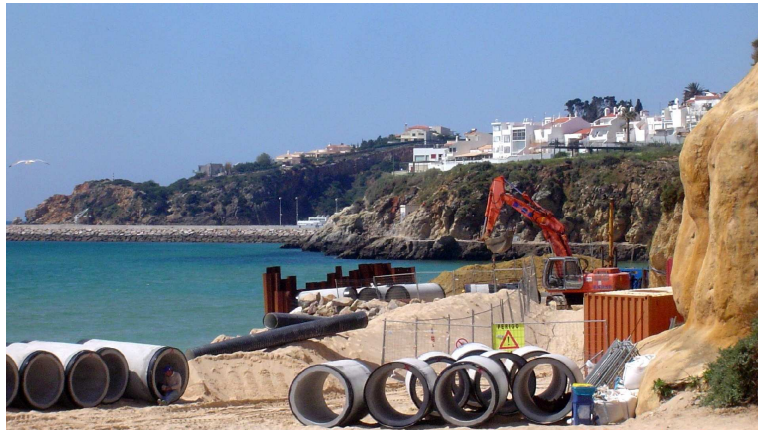
Figura 10 – Construção do Emissário Submarino de Albufeira
