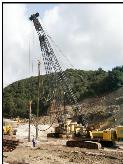
Figura 4 – Grua e vibrador.
