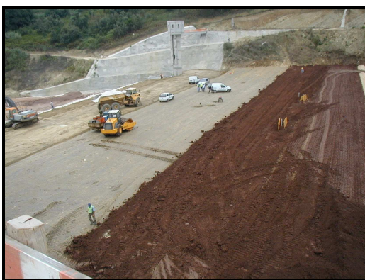
Figura 9 – Aterro, maciço de montante e núcleo. Figura 10 – Protecção do tapete impermeável.
