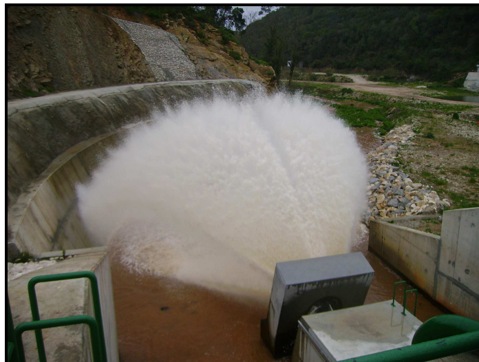
Figura 13 – Descarga de fundo, válvula de jacto oco.
