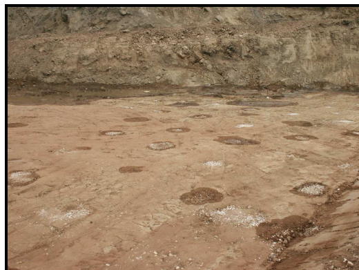
Figura 6 – Aspecto das colunas após saneamento.
