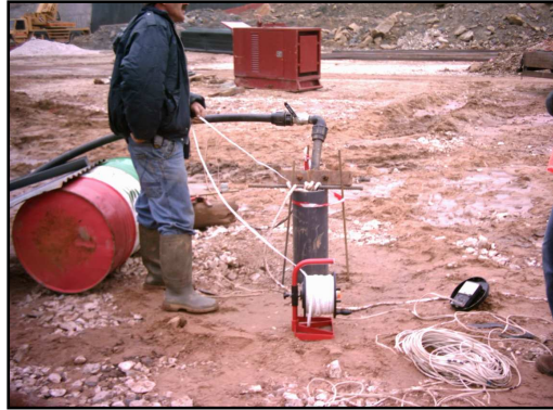
Figura 7 – Ensaio de permeabilidade.
