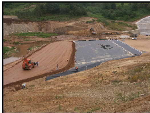
Figura 9 – Aterro, maciço de montante e núcleo. Figura 10 – Protecção do tapete impermeável.
