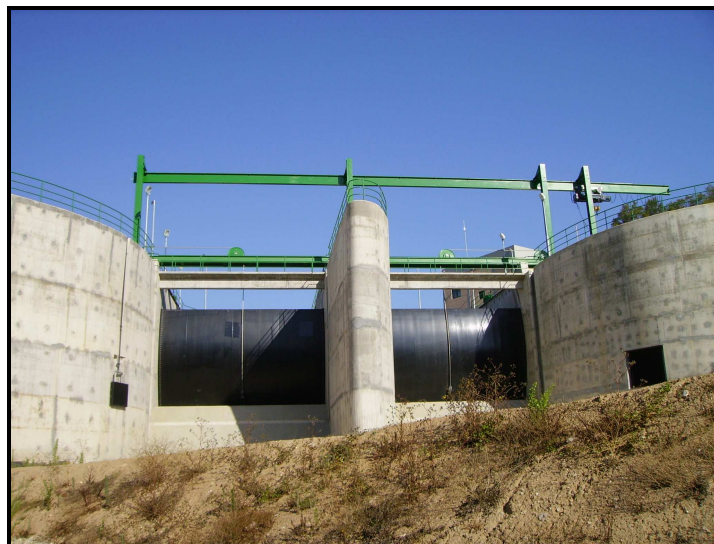
Figura 11 – Descarregador de cheias montante.
