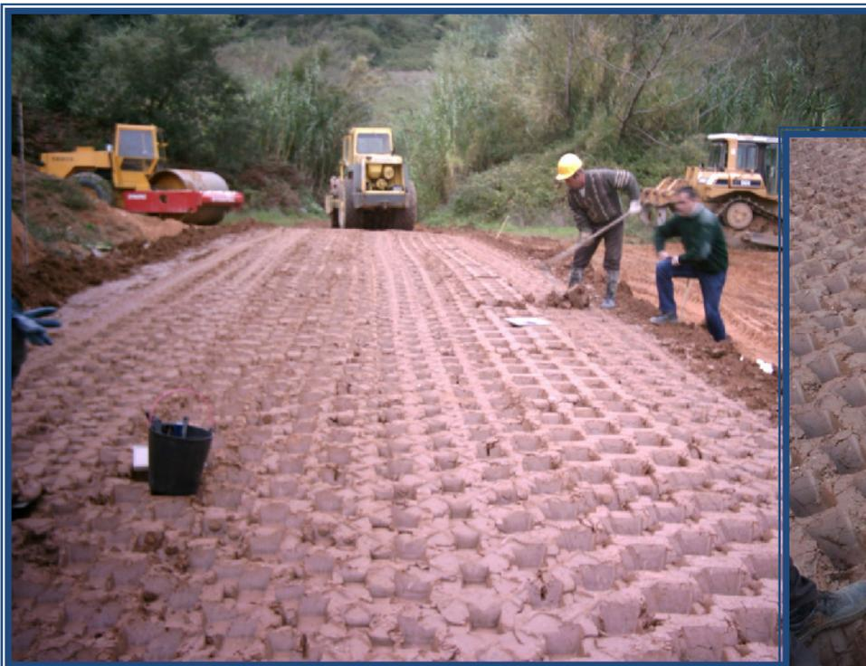
Execução de aterros experimentais e ensaios de compactação
