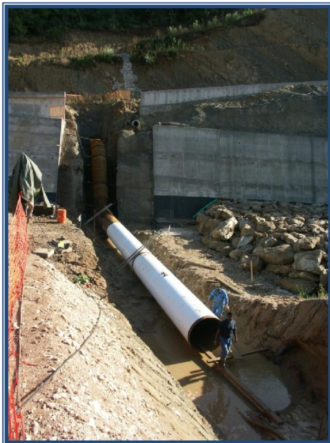
No fim da galeria a conduta de tomada de água atravessa, em vala escavada no leito do rio, para a margem esquerda, local da futura E. de Bombagem.
