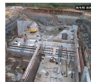
Considerando o facto das estruturas serem fundadas sobre estacas (52 estacas de betão armado com Ø 1,0 m e 40 m de comprimento) procurou-se uma solução compacta tornando desse modo a obra o mais económica possível.
