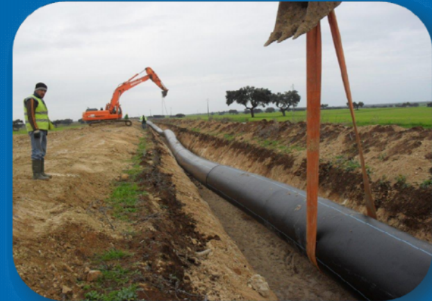
coloca-se com cintas após soldadura fora da vala
