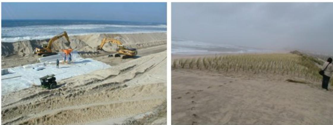
Figura 1 - Processo construtivo da barreira de protecção e replantação da zona intervencionada (Antunes do Carmo, Janeiro 2006)
