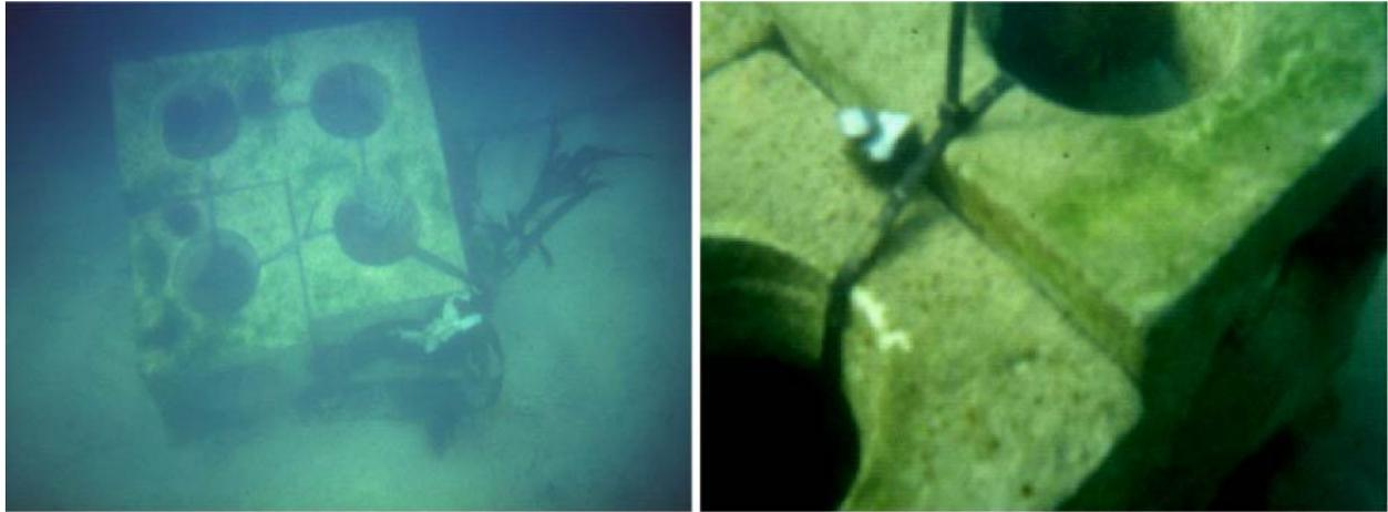
Figura 4. Recife artificial depois de montado no fundo. Os oito módulos que o constituem estão presos uns aos outros com abraçadeiras de plástico (esquerda). Pormenor da ligação entre os módulos (direita).
