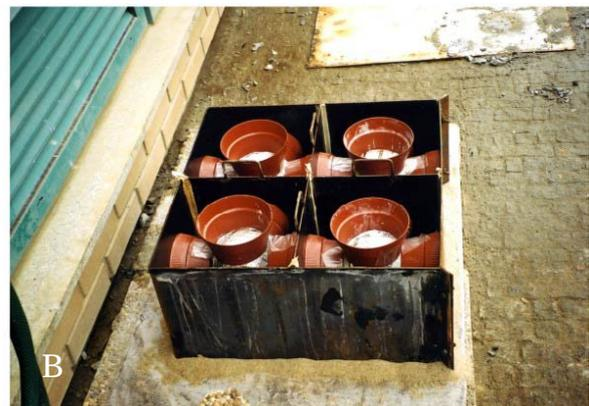
Figura 2. A – Cofragem em chapa de ferro usada para a construção dos módulos. B – cofragem completa e pronta a ser betonada.
