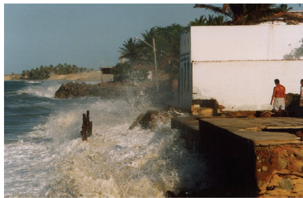
Foto 6 – Erosão costeira na região metropolitana de Fortaleza. Photo 6 - Coastal erosion in the metropolitan region of Fortaleza.
