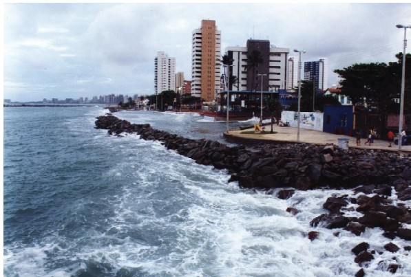
Foto 7 – Muro de pedra para proteção costeira na Praia de Iracema em Fortaleza.
