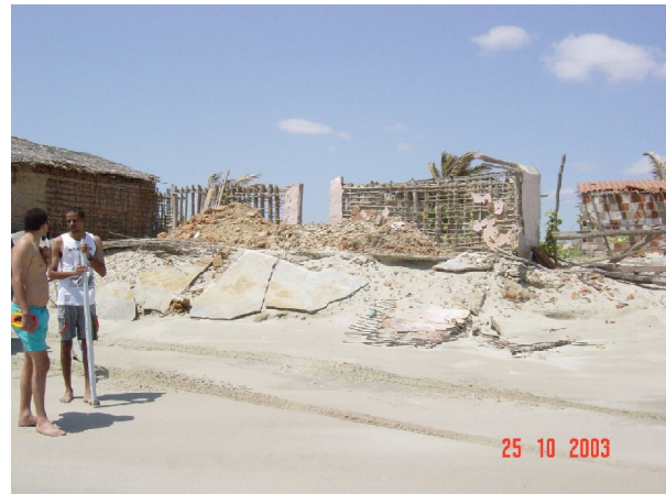
Figura 17 (b) - Ruínas de uma casa localizada nas proximidades do Perfil Manuelas II, resultado do efeito erosivo na linha de praia em 2003. Figure 17 (b) - Houses in ruin located near Manuelas II beach profile showing the erosive effect in 2003.
