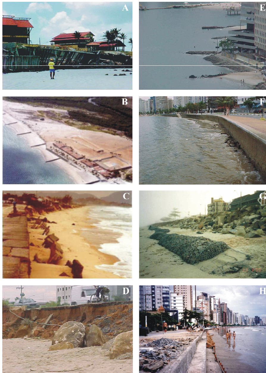
Figura 3. Exemplos de praias brasileiras com erosão severa e implantação de obras de proteção ou contenção equivocadas. A. Praia do Farol Velho, Pará (Pedro W.M. Souza, 2002); B. Praia de Canapum, Rio Grande do Norte (Helenice Vital, 2001); C. Praia de Piratininga, Rio de Janeiro (Soraya Patchineelam, 2002); D. Praia de Massaguaçu, São Paulo (autora, 2007); E. Praia do Gonzaguinha, São Paulo (autora, 2007); F. Praia do Gonzaguinha, São Paulo (autora, 2007); G. Praia de Caiobá, Paraná (autora, 2000); H. Praia de Camboriú, Santa Catarina (Luciana S. Esteves, 1999).
