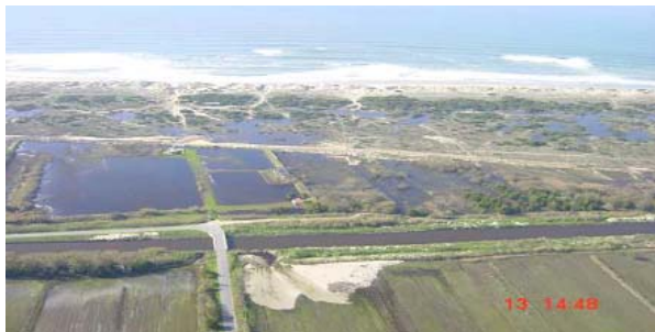
Figura 2: Erosões, galgamentos das dunas e risco de ruptura da restinga na Costa Nova - Vagueira
