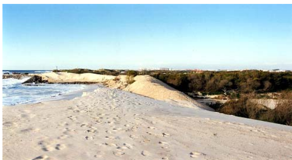
Figura 4: Dique arenoso artificial colocado em situação de emergência face à rotura eminente do cordão dunar a sul da Vagueira.
