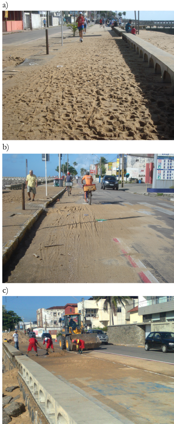
Figura 19. O volume de sedimentos aportado na praia de Bairro Novo é superior à capacidade dos compartimentos e invadem as calçadas e a pista de rolamento. Imagens A, B e C. Fonte: Acervo do Autor (2009).
