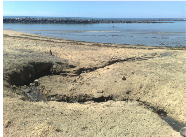
Figura 12. Despejo contínuo de efluentes na praia do Carmo, interferindo na morfodinâmica praias através da formação de sulcos erosivos provenientes do curso d'água, imagens A e B.
