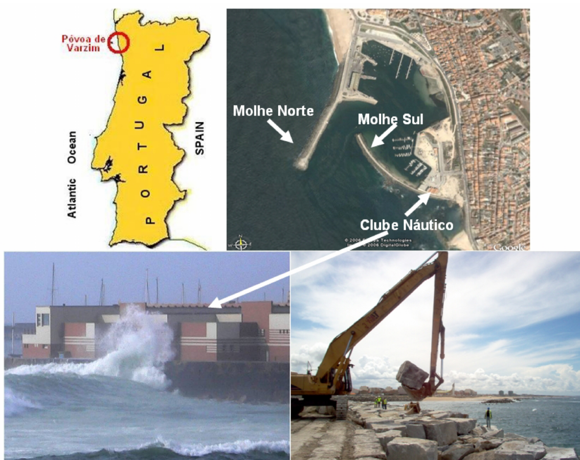
Figura 2 - Porto de pesca da Póvoa de Varzim: localização, vista aérea, galgamentos ocorridos no molhe Sul em Março de 2006 e aspecto da reabilitação que estava a ser efectuada ao molhe em Junho de 2009.
