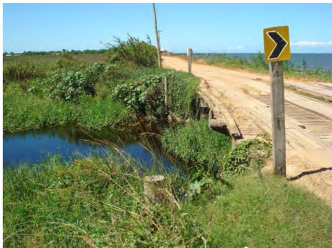
Figura 4 - Ponte de acesso à Colônia de Pescadores Z3, sobre o canal Reasilva. Detalhe para o aterro consolidado para a construção da estrada e que secciona a conexão natural existente entre as áreas de banhado (à esquerda) e a Laguna dos Patos (à direita). Fonte: Delamare
