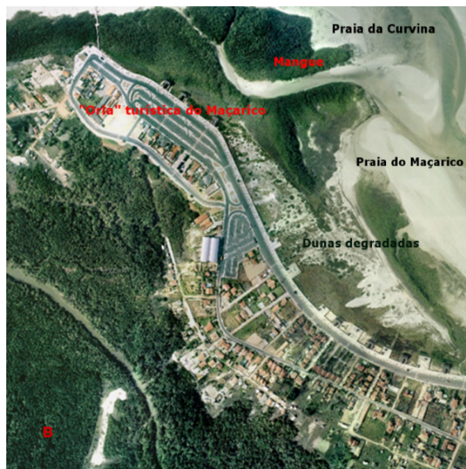
Figura 9: Orla turística do Maçarico (B). Para a construção de aproximadamente 2 km de orla, foi derrubado vegetação de mangue e restinga e a compactação do solo com aterro e concreto. A vegetação de mangue e as dunas que se formaram paralelamente à “Orla” tem funcionado como barreiras de proteção da estrutura ao ataque das ondas. Foto: COHAB, 2000.
