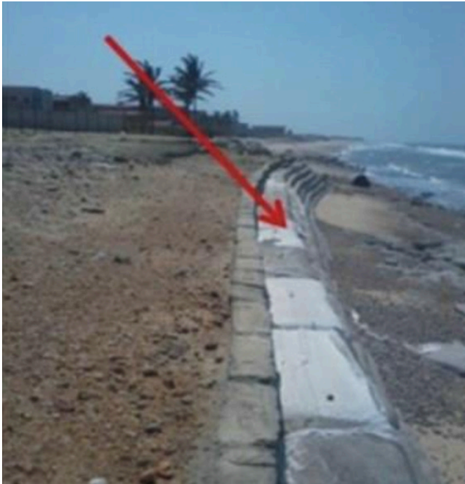
Figura 7. Obra de contenção costeira na Praia do Icaraí.
