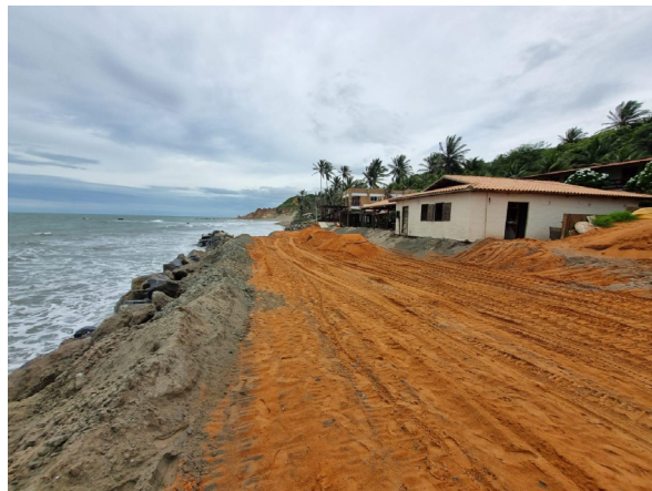
Figura 8. Construção da estrada de acesso para a implantação do primeiro dos dois espigões da Praia da Peroba. Fonte: Maia et al. (2024).
