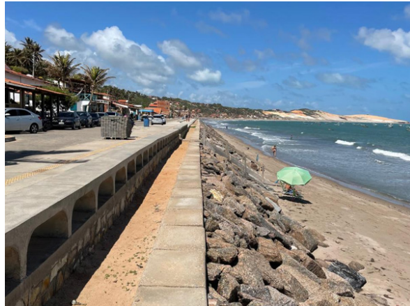
Figura 4. Defesa costeira do tipo enrocamento aderente na praia de Redonda, também no município de Icapuí, Ceará. Fonte: Maia et al. (2024).
