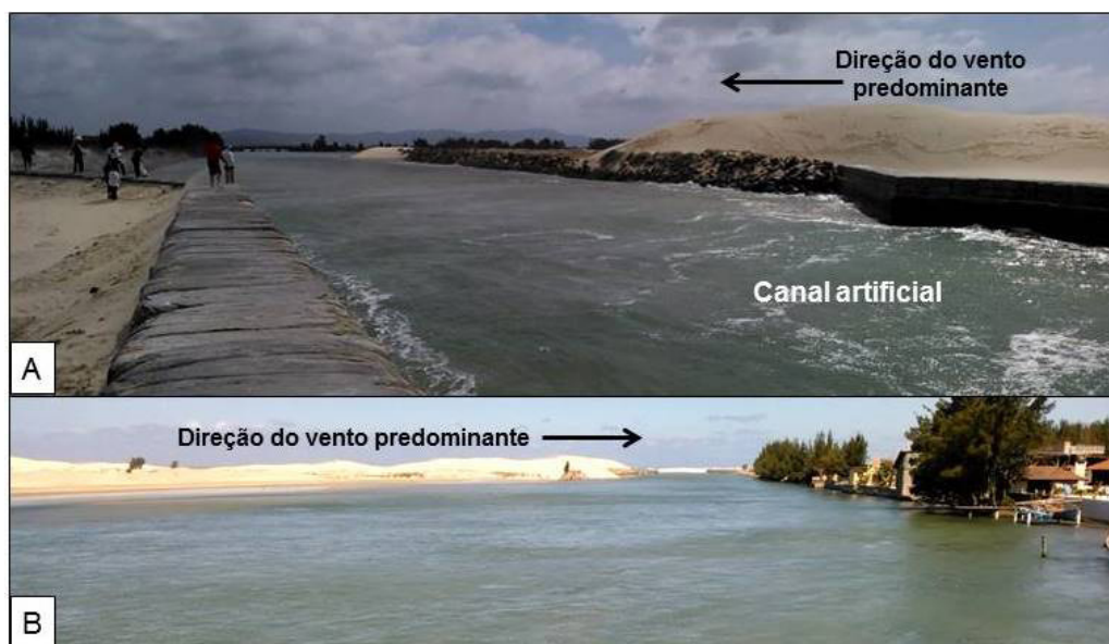
Figura 3 - Sistema de dunas móveis provenientes de norte-nordeste, adentrando o canal artificial do Camacho, o que pode acarretar problemas sérios devido a alterações na dinâmica sedimentar. A) Vista para o continente; e B) Vista em direção do mar.
