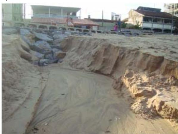
Figura 21. O volume de despejo dos drenos expulsa os sedimentos e aportados e altera severamente o perfil praial, impondo a este trecho da praia de Bairro Novo um novo cenário de erosão costeira (imagens A e B).
