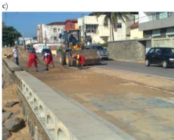
Figura 19. O volume de sedimentos aportado na praia de Bairro Novo é superior à capacidade dos compartimentos e invadem as calçadas e a pista de rolamento. Imagens A, B e C.
