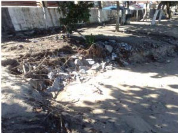
Figura 11. Praia do Carmo – Vista da faixa de pós-praia após a erosão provocada pelo extravasamento de um coletor de águas pluviais. (imagens A e B).
