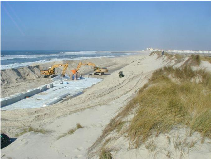
a) Instalação de mantas de material geotêxtil, em 11 de fevereiro de 2005.
