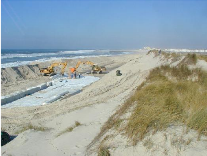
a) Instalação de mantas de material geotêxtil, em 11 de fevereiro de 2005. a) Installation of geotextile wraps on February 11, 2005.
