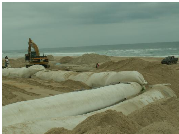
b) Instalação de tubos pré-fabricados em material geotêxtil em 22 de julho de 2008.
