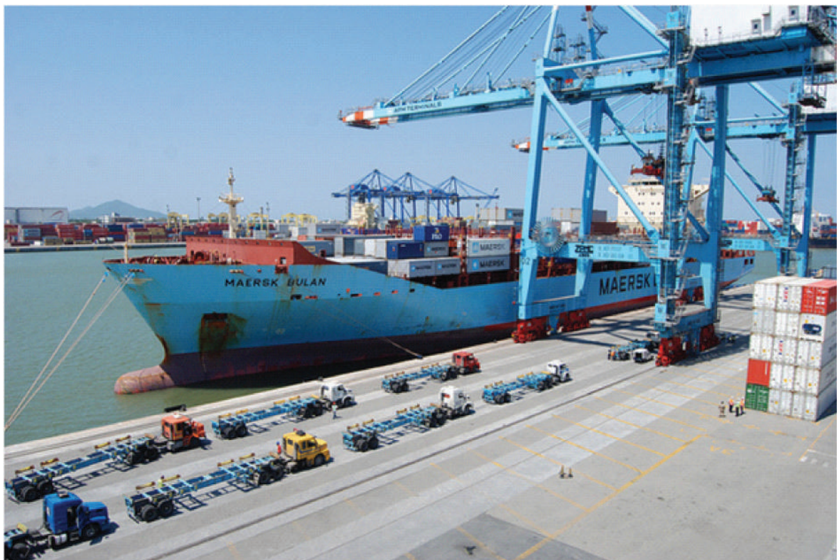
Figura 2. Guindastes de carga e descarga de mercadorias.
