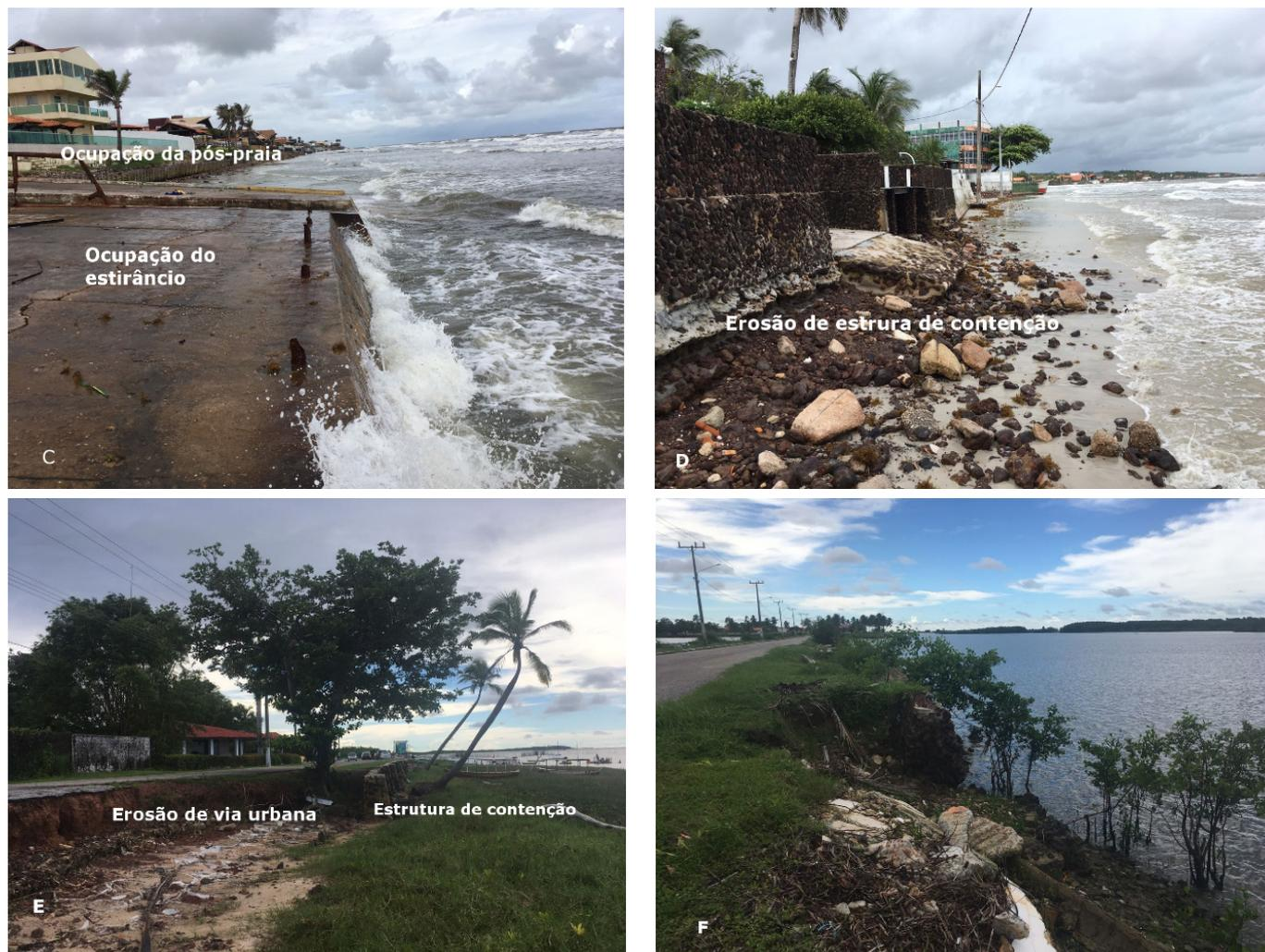
Figura 10: Ação das ondas e correntes longitudinais e de marés sobre estruturas artificiais: (C) Setor da praia do Atalaia, em Muito Alta Vulnerabilidade, sofrendo ataque das ondas; (D) Setor da praia do Farol Velho em Muito Alta vulnerabilidade, apresentando intenso processo erosivo; (E e F) Setor de Falésia Leste, a ação, principalmente das correntes de marés tem provocado erosão nas vias de circulação. Fonte: Fotos de Ronaldo Braga (08/04/2018).
