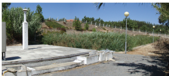
Figura 2 – Vista geral da ETAR de Fataca.
