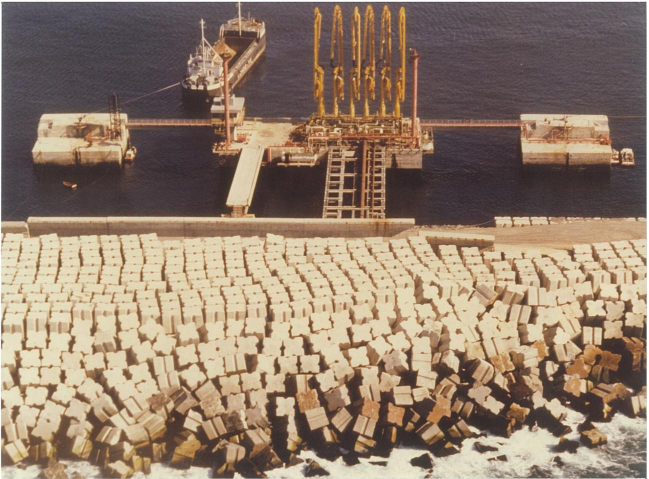
**Figura 9.** Vista aérea da Reparação do Molhe Oeste de Sines.
