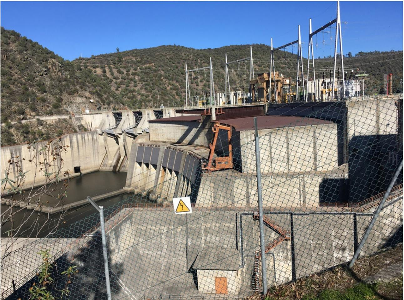
Figura 3 – Pormenor da barragem de Cedillo. O caudal efluente da barragem é nulo, como ilustrado na fotografia. Esta situação ocorre durante a maior parte do tempo, exceto nos períodos em que os caudais afluentes à albufeira, gerados na parte da bacia hidrográfica do Tejo em território de Espanha são elevados. Fotografia gentilmente cedida por Maria Manuela Portela.
