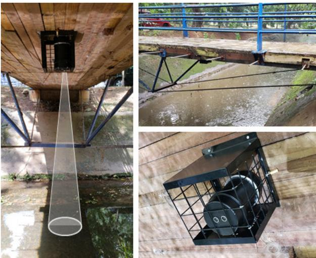
**Figura 4.** Sensor ultrassônico e local de aferição de medidas.
