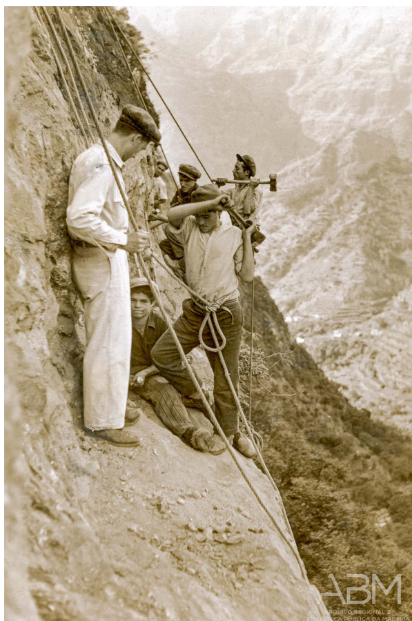
Figura 5. à esquerda: Construção da Levada do Norte, o engenheiro e os operários, foto; E.N. Pereira, Arquivo Regional e Biblioteca da Madeira ABM; PT / ABM / ENP / C / 007-007 / 24-83 Levada do Norte - abertura da esplanada no local da Tapaginha, próximo da Encumeada, vendo-se os operadores amarrados com cordas na encosta; à direita: vista de hoje da levada.
