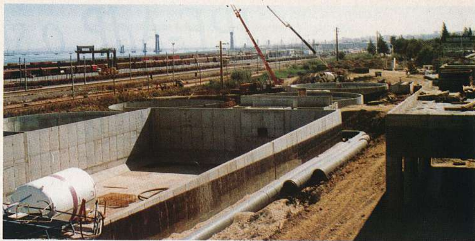
ETAR de S. João da Talha, em construção
