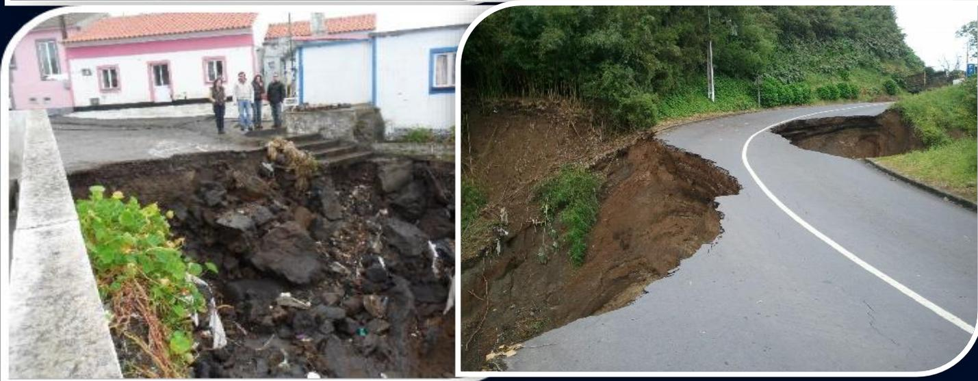
Fenómenos de erosão hídrica são frequentes na Região e decorrem do escoamento superficial potenciado pelo **regime pluviométrico**, pelo tipo de **ocupação do solo** e pelo tipo de **formações litológicas** existentes, conjuntamente com inadequados padrões de uso do solo que contribuem para o aumento do potencial erosivo provocando situações que têm estado na origem de inúmeras ocorrências.
