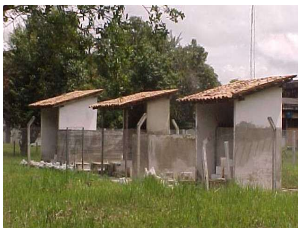
Fotografia 3 - Sistema Experimental de Desaguamento de Lodo – UFPA.
