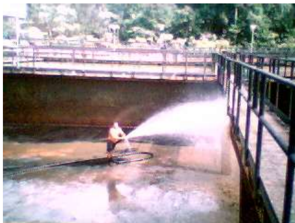
Fotografia 2 - Limpeza dos decantados da ETA-Bolonha.
