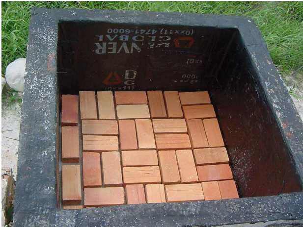
Fotografia 4 - Camada suporte de tijolos recozidos maciços.
