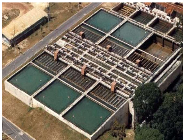
Fotografia 1 - Vista aérea dos seis decantadores da ETA Bolonha.
