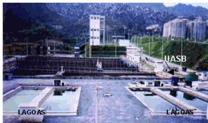
Figura 1: Vista do reator UASB e das quatro lagoas de polimento – ETE Experimental Arrudas.
