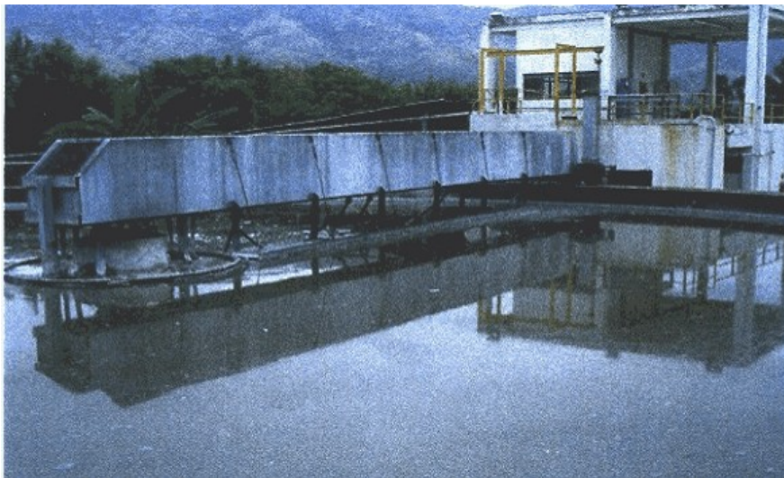
Figura 2: Foto do decantador primário estudado
