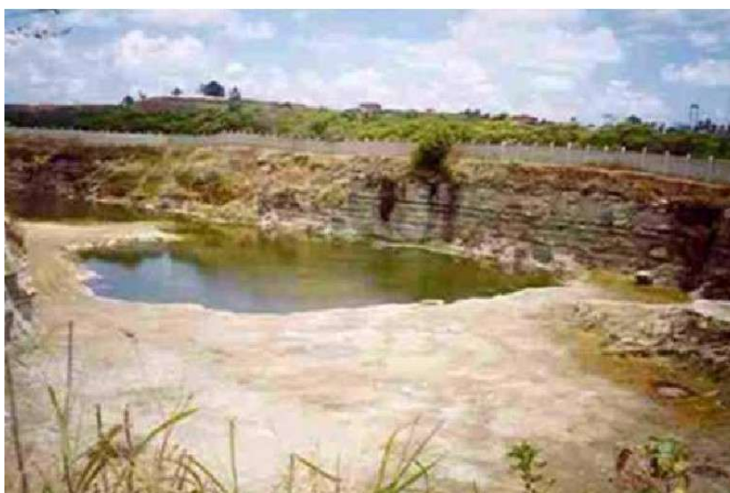
Figura 1: Vista da lagoa anaeróbia construída sobre área degradada pela exploração de calcário, antes de entrar em funcionamento.
