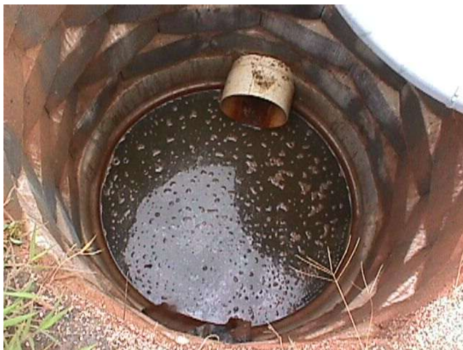
Figura 2. Poço de acumulação de chorume no Aterro Sanitário de Pirai.
