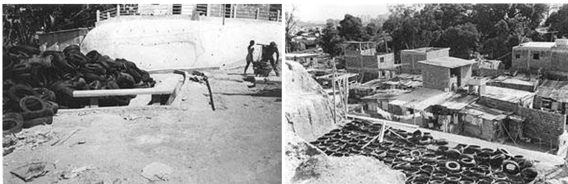
FIGURA 9 - Fases da construção dos muros de contenção de encostas
