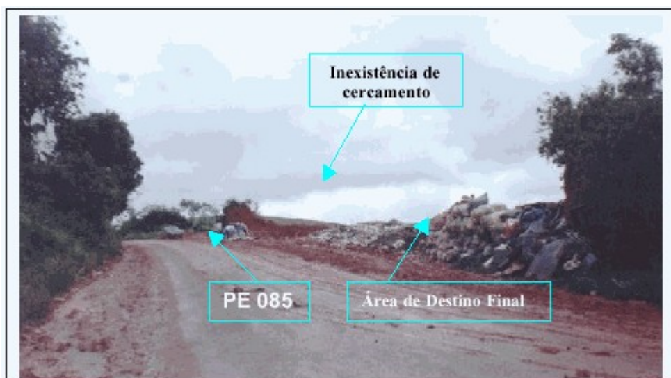
Figura 4 – Visualização entre a PE e a área de destino final
