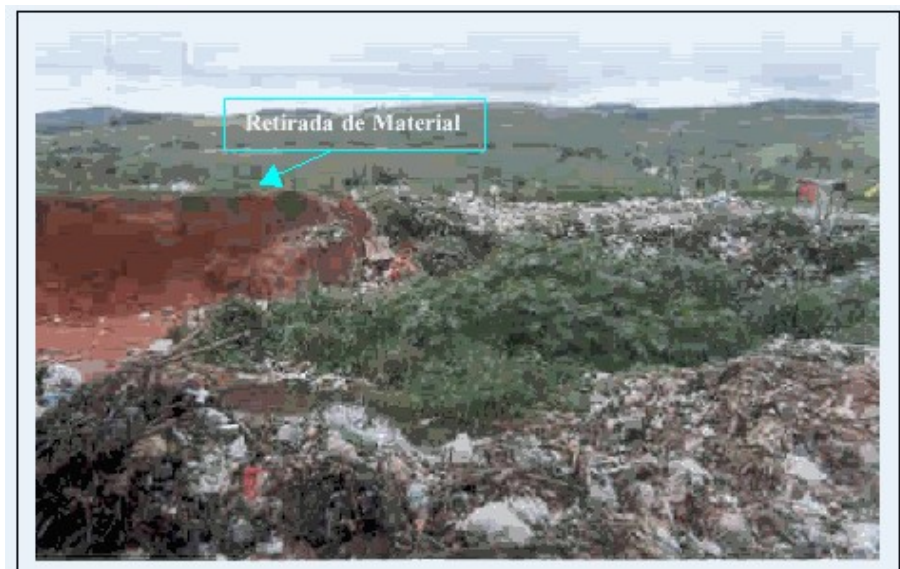
Figura 3 – Retirada de material de recobrimento para comercialização
