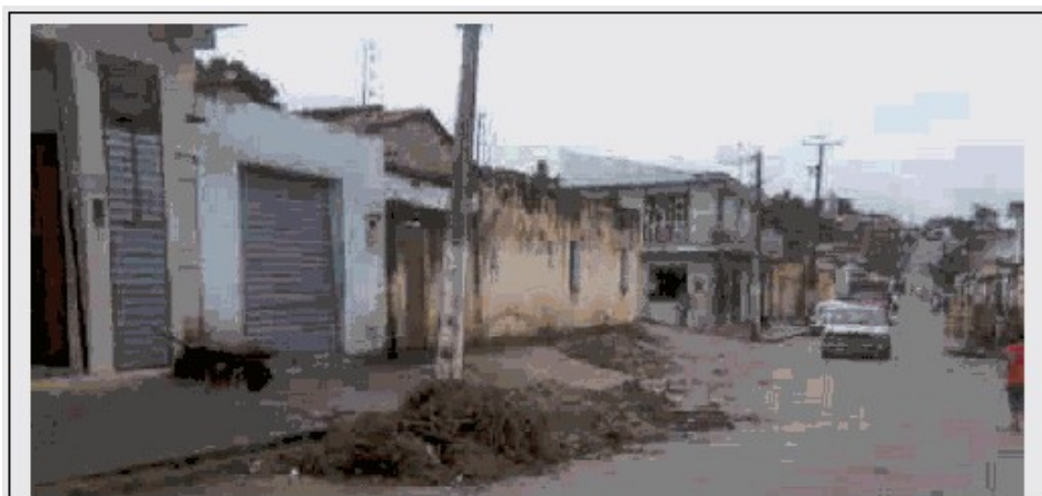
Figura 2- Disposição de resíduos de entulho nas ruas
