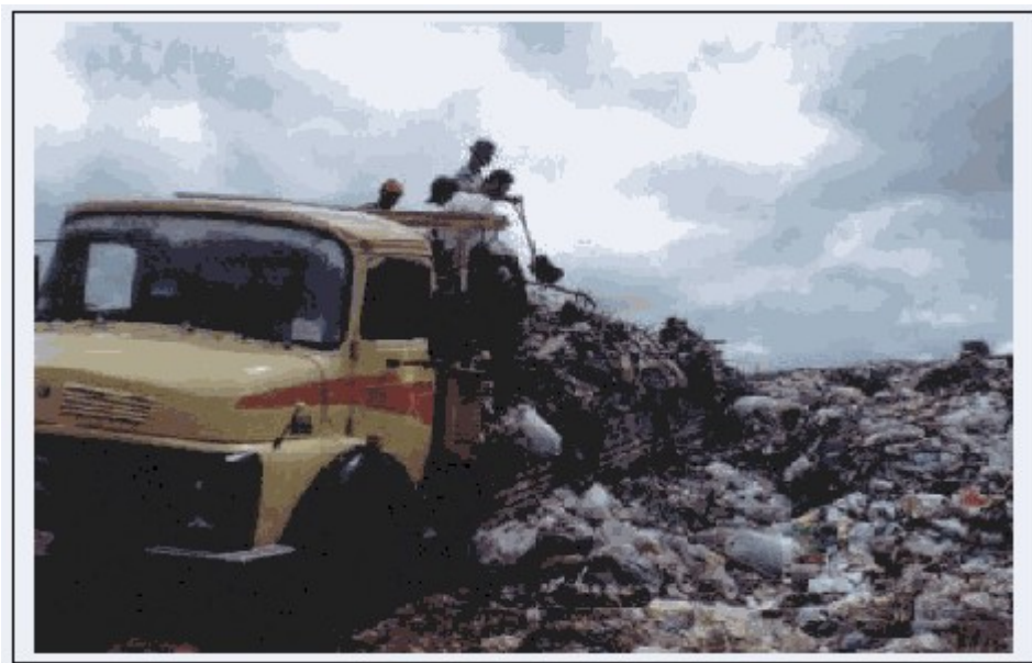
Figura 6 – Caminhão por cima dos resíduos, pois não existe via de acesso adequada.
