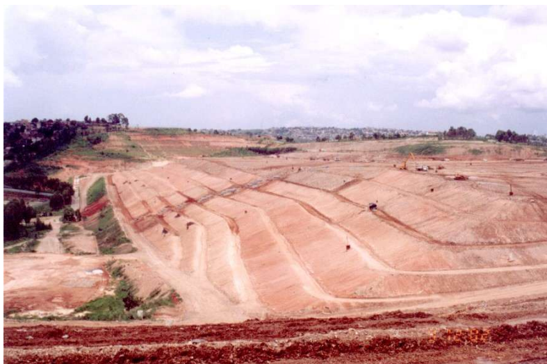
Figura 2 – Visão geral dos taludes das Células AC-03, AC-04 e AC-05
