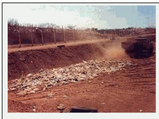
Fotografia 4: Recobrimento dos resíduos no aterro
