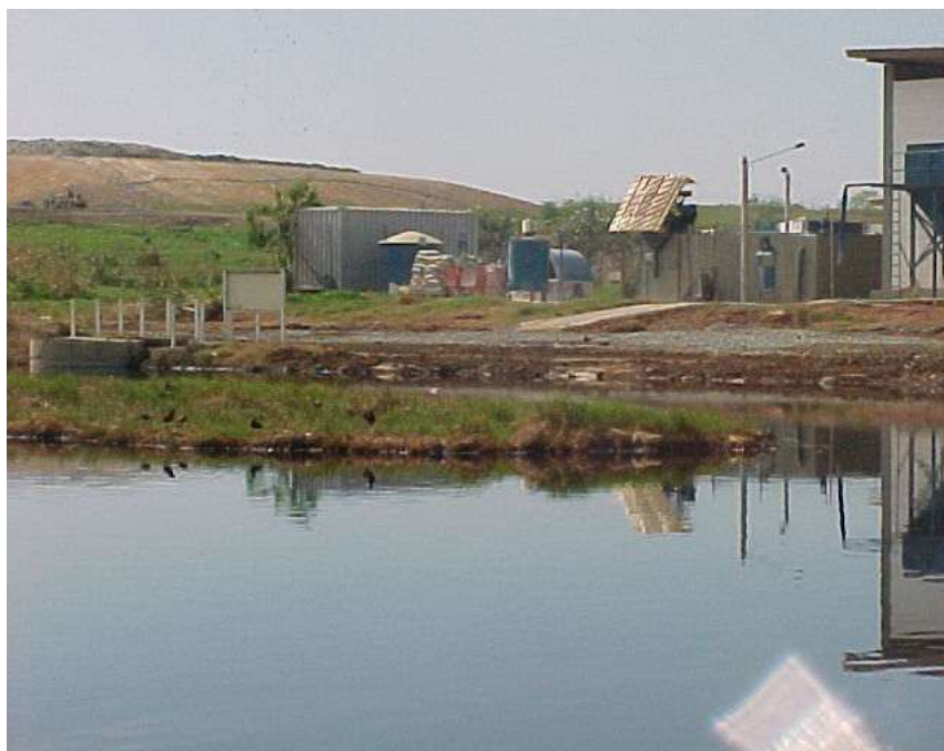
Figura 2. Ilhota de gramínea na margem da lagoa de estabilização.
