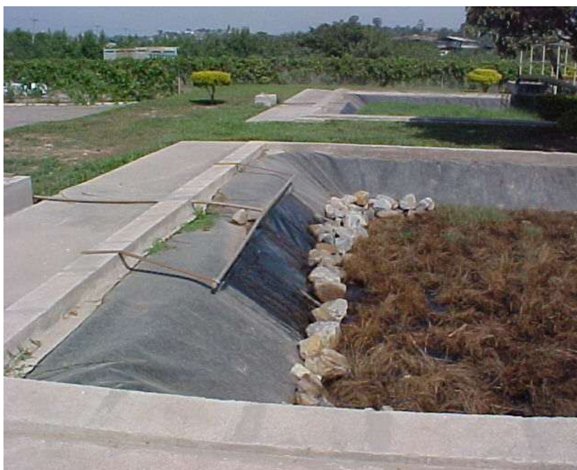
Figura 4 . Sistema de alimentação do chorume no wetland .
