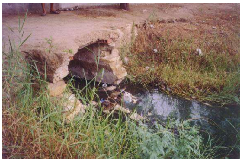
Figura 5: Valas e barreiras físicas ao acúmulo de resíduos sólidos domiciliares nas margens do rio Mossoró.
