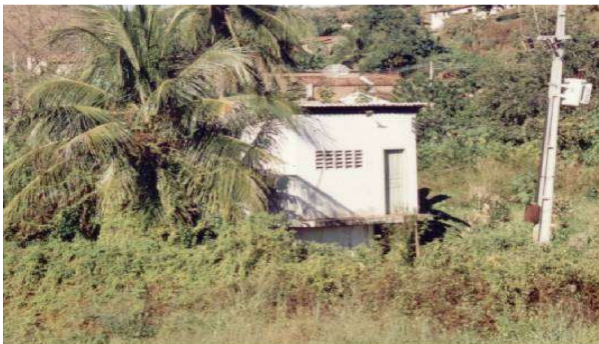
Figura 6 – Poço utilizado para o abastecimento público, situado nas margens do rio Jatobá
